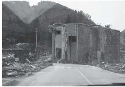
資料2 被災状況
