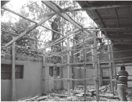
図1 教室のリフォーム工事
