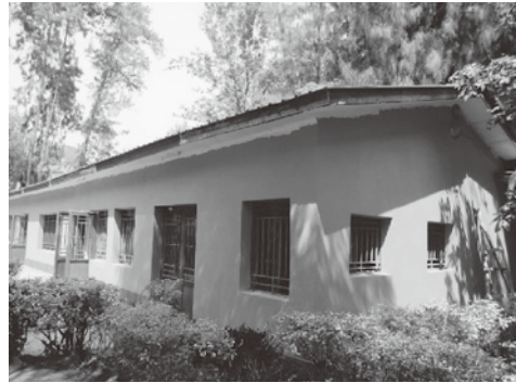
図2 完成した教室外観
