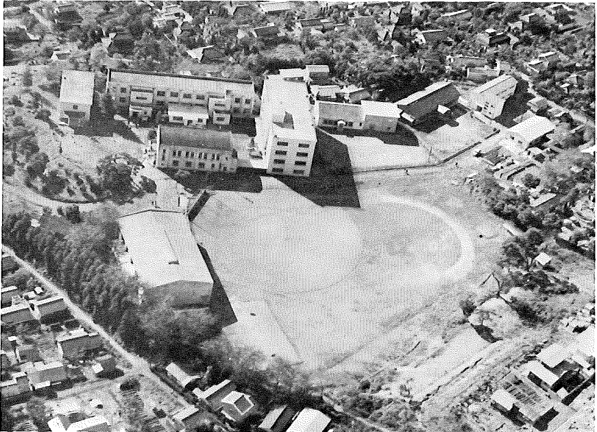
構内風景（昭和36年頃・航空写真）
