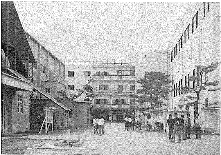
第一号館増築
