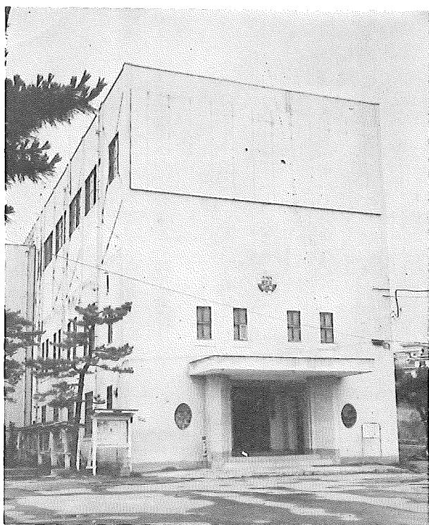
講堂棟三階竣工
